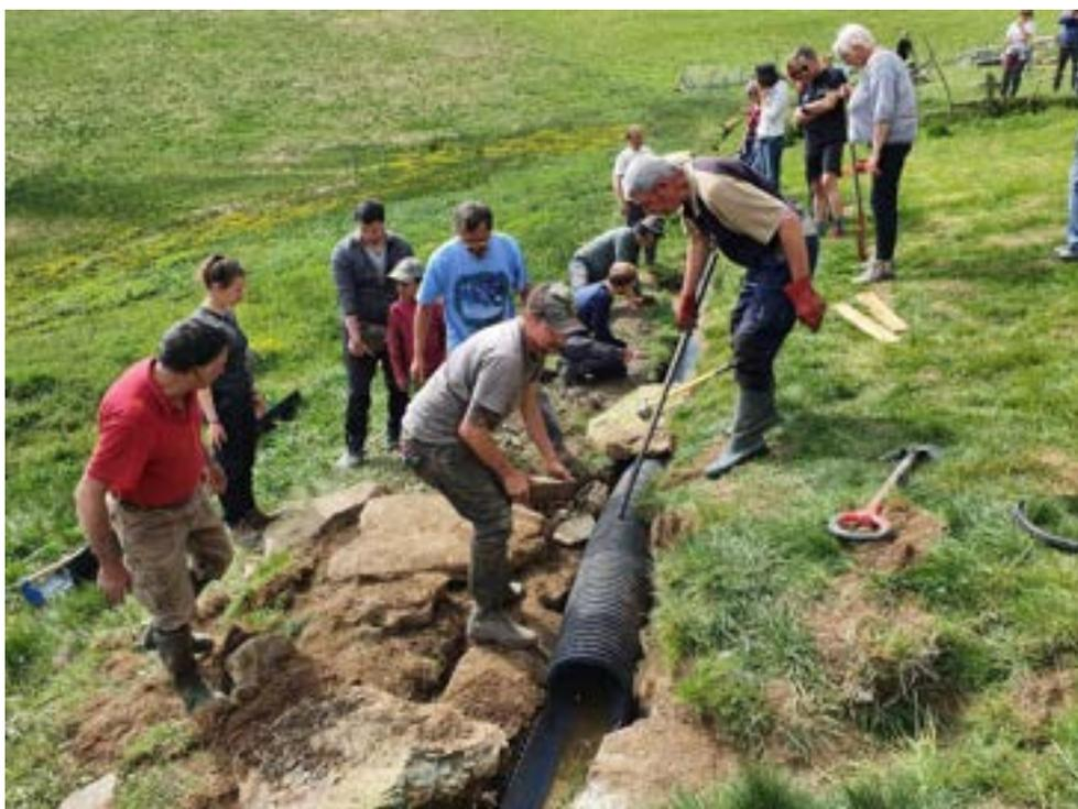
Renforcement d'un passage automobile par-dessus une rigole au Sarrat de Gaye Chantier organisé par l'Association des Rigoles de Gaye : © OAPHB 2022
