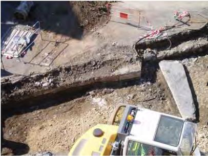
*Travaux Place d'Albret. 2012. Destruction du canal de la Nasse et du pont de l'Oretto situé dans l'axe des rues de Salies et de l'Horloge. Le canal était pavé de galets, les berges étaient soigneusement maçonnées. L'angle en pierre de taille correspondait au bassin Charles X. On voit ici, déposée, une des « lavasses » qui formaient pont et permettaient de passer le canal sans dos d'âne. A Bagnères le réseau hydraulique médiéval affleure sous la surface de la voirie contemporaine.*
