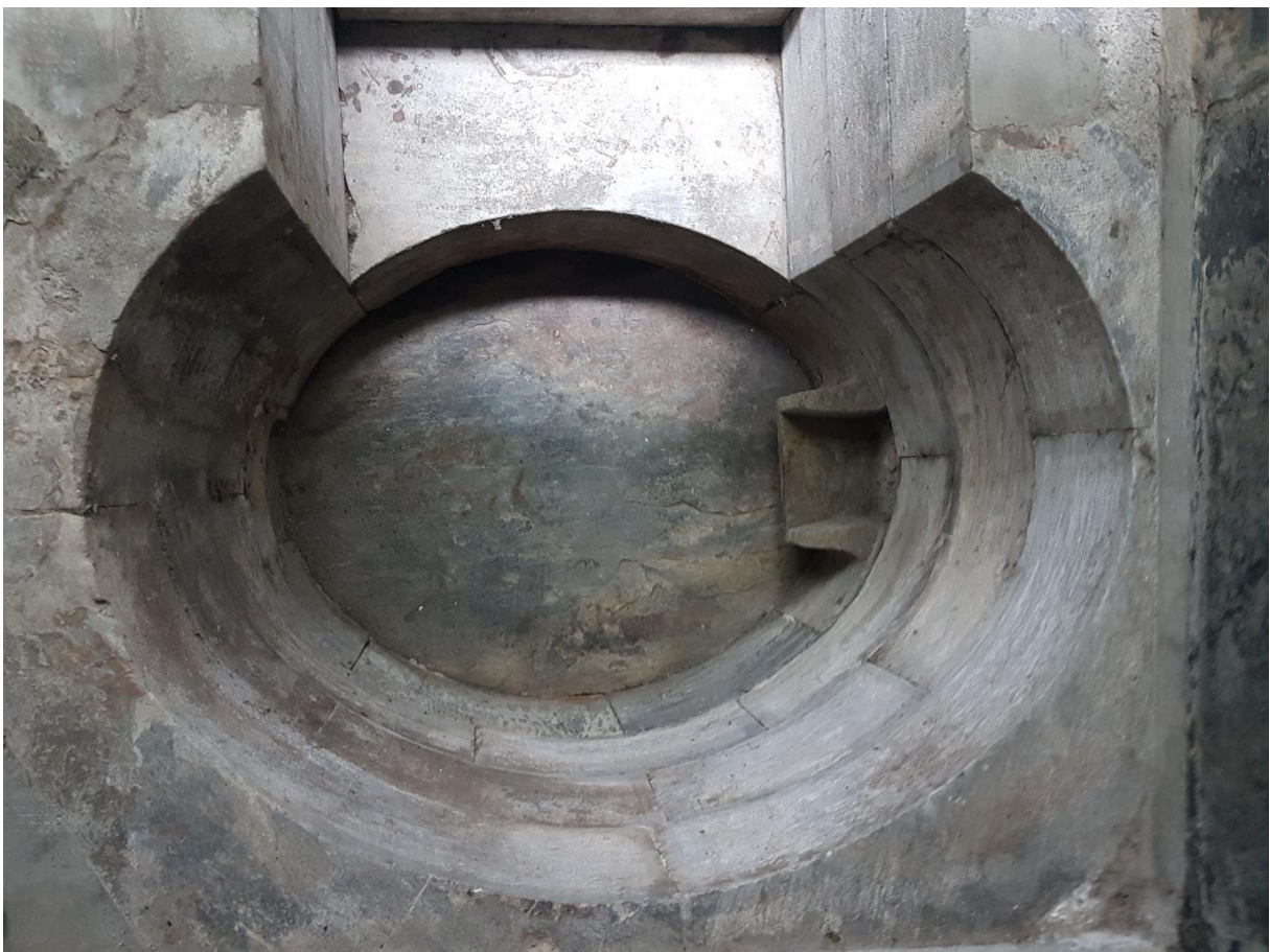
Cuvette à Bagnères-de-Bigorre, bassin appareillé anciennement desservi par un petit canal traversant enterré © OAPHB 2017
